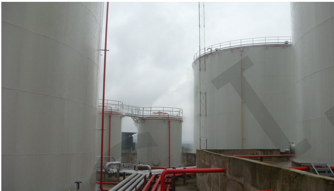
Couronnes avec buses BM-H K20 en eau et en mousse respectivement
