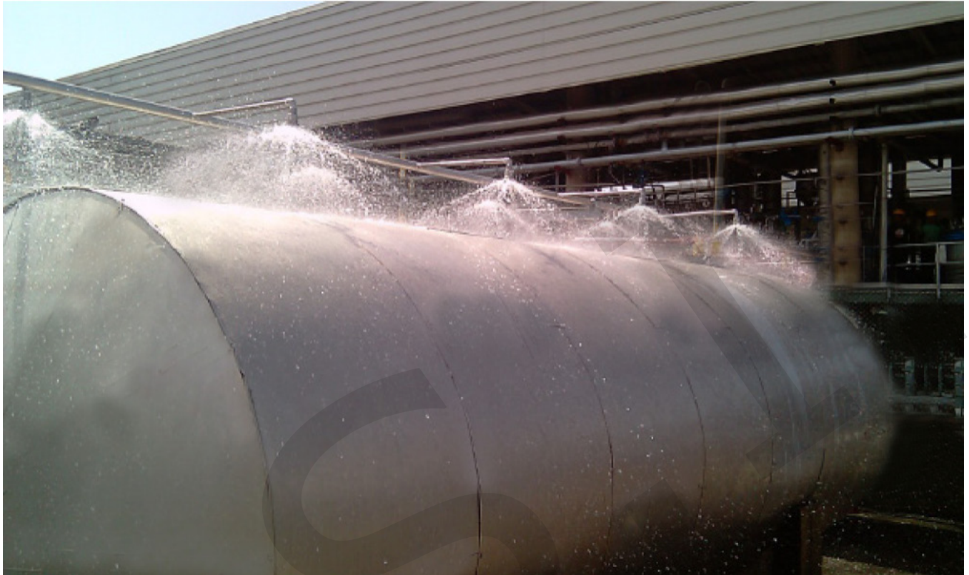
Rampes Mixtes Eau et mousse testées en Eau sur parc de Stockage d'Acétone
