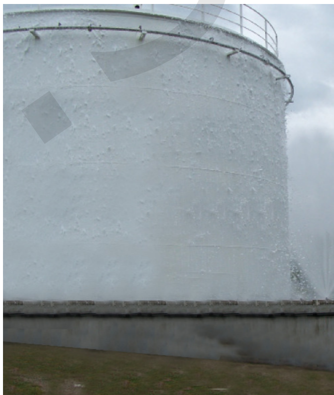
Couronnes avec buses BM-H K20 en eau et en mousse respectivement
