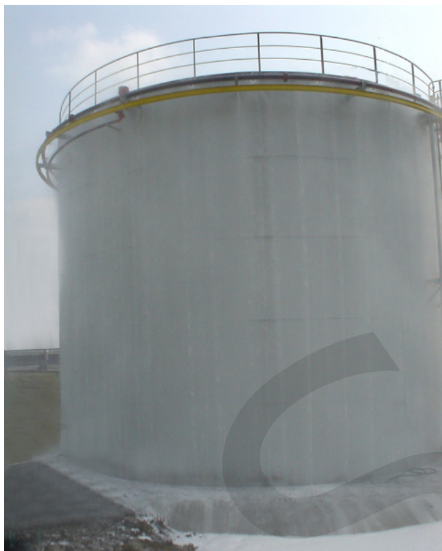
Exemple d'utilisation en eau dopée avec un AFFF
