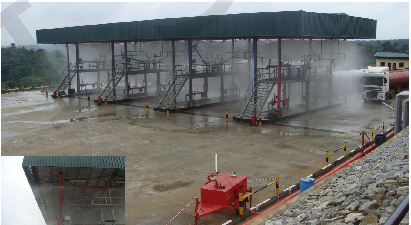
Protection de Dépotage par rampes Mixtes eau / Mousse
